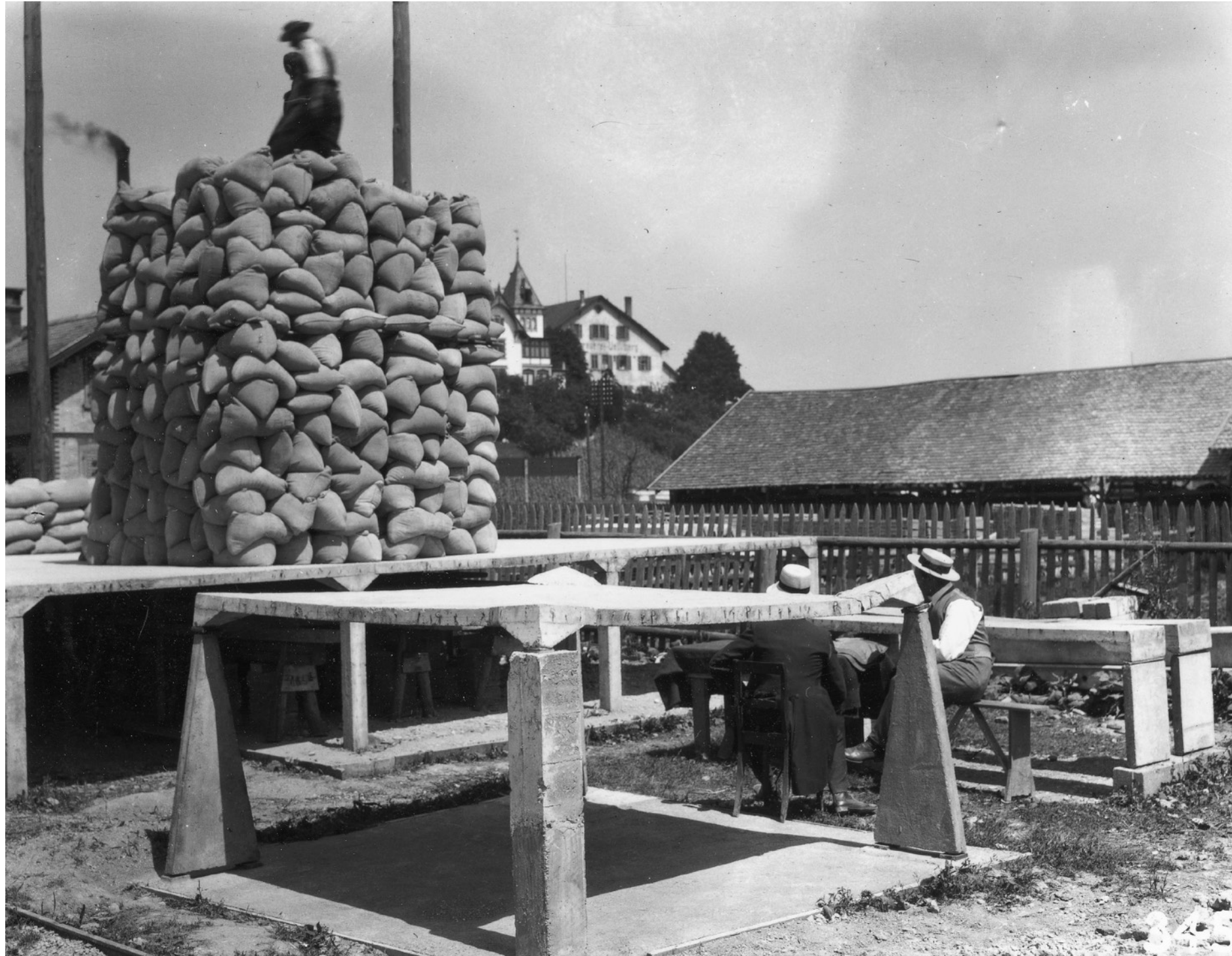
Maillart & Cie, Platten- und Balkenversuche, 1908
