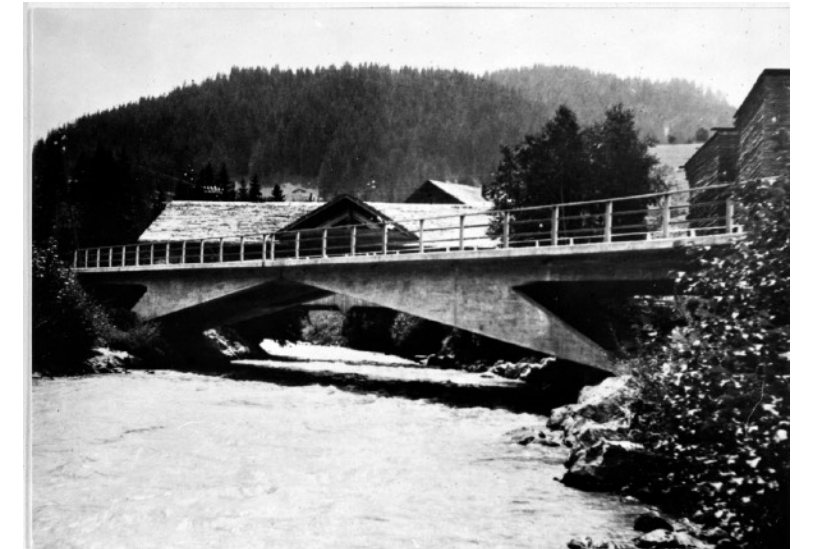
7_Brücke über die Simme, Garstatt, 1939/40, 32.0m
