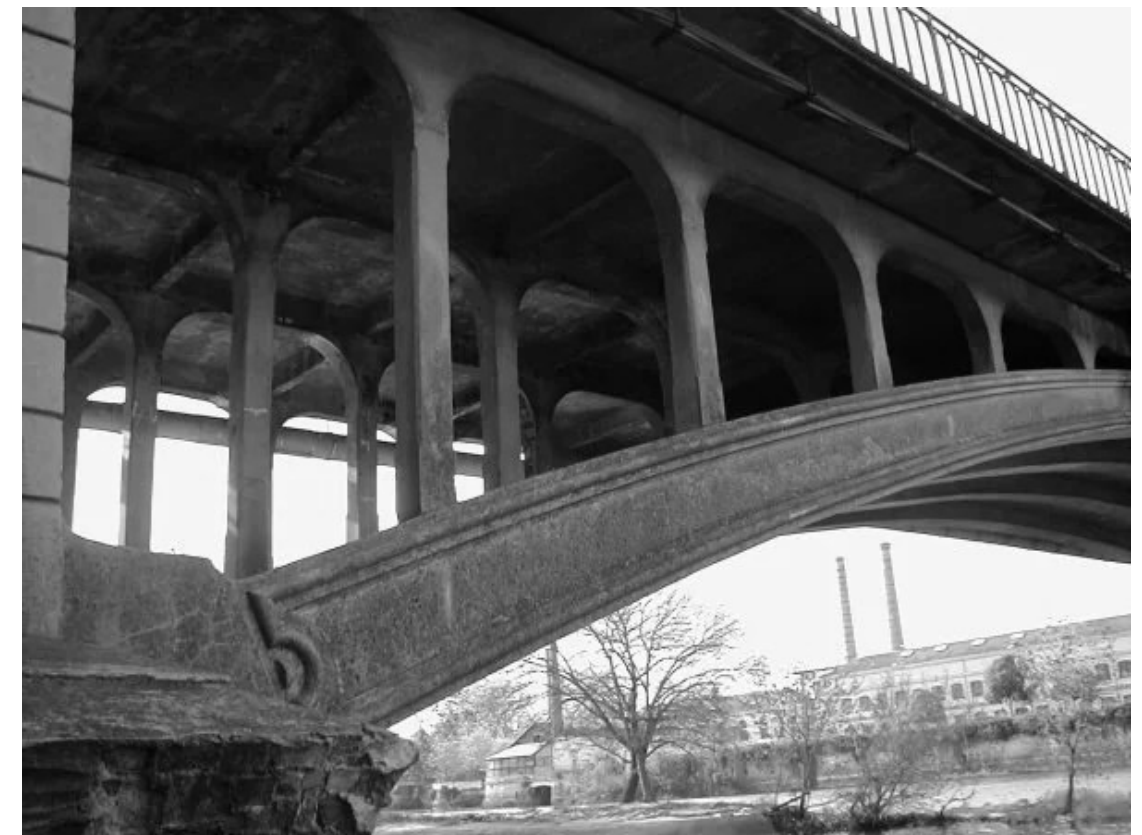
Pont sur la Vienne, Châtelleraut, 48.0m, 1899 Système Hennebique
